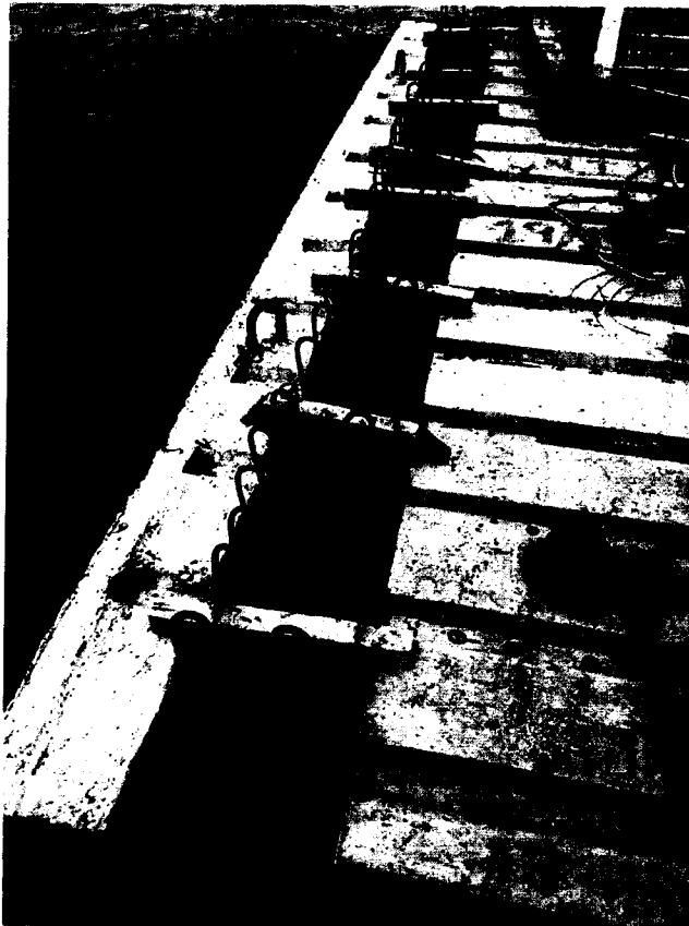
FOTO 11: Encofrado en la zona del cabezo
